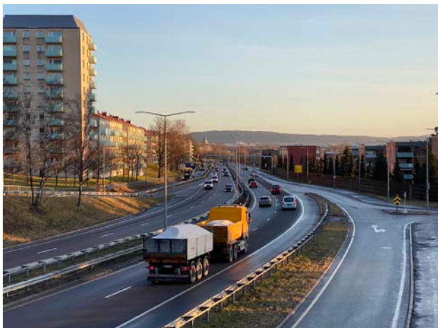
Trondheimsveien, RV4, skaper en barriere mellom områdene på hver side. De nærmeste boligene ligger innenfor rød støysone i kart utarbeidet av Statens veivesen.
