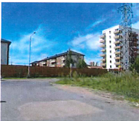
Der det mangler en forbindelse i grønnstrukturen, er det nå også satt opp støyskjerm langs Brobekkveien..
