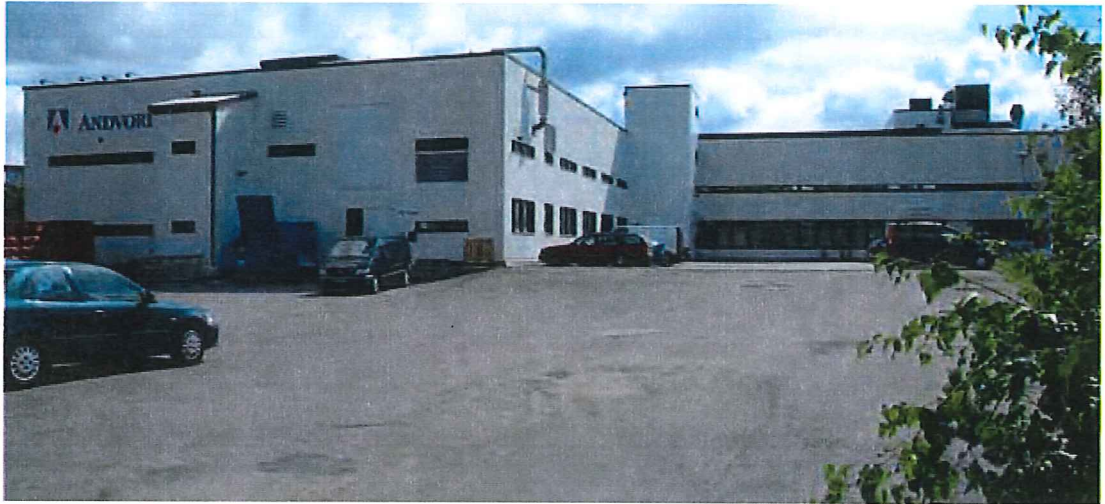
Andvordbygget har romslige atkomst- og parkeringsarealer.
