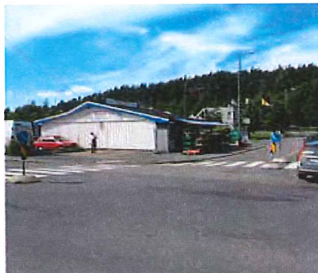
Kiosk på Linderud, omkranset av Trondheimsveien og Erich Mogensønns vei.
