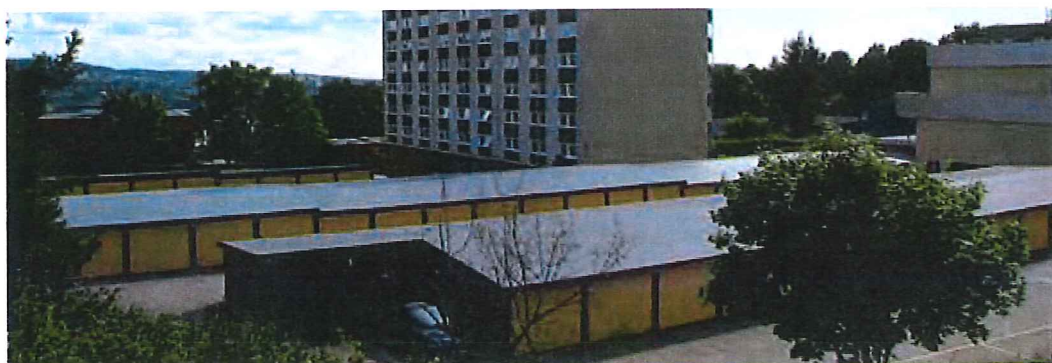
Utvidelsen av garasjeanlegget nær Linderud senter.
