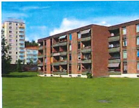
Felt V: Uteområdene er velholdt, men uten særlig tilrettelegging for lek og opphold.
