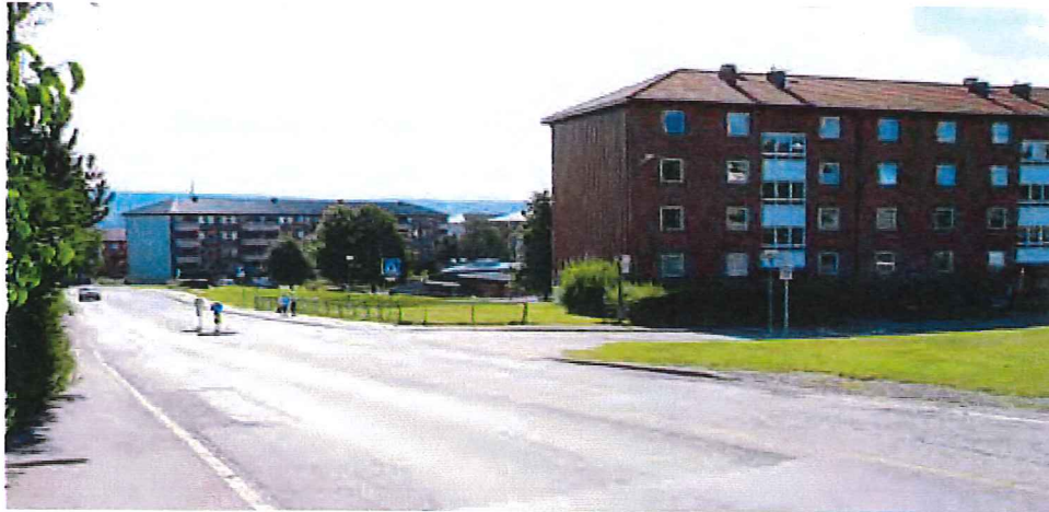
Felt B: Teglblokkene ved Bjerkeparken sett østover fra Refstadveien. Turvei krysser veien og går inn i parken. Barnehagen skimtes midt i bildet.
